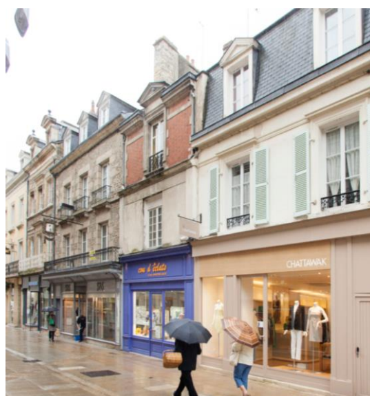
29/31 rue aux Sieurs – Alençon (61)
