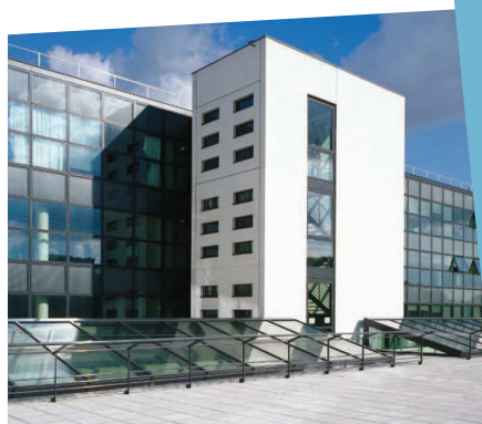
Immeuble de LYON « Confluent 2 »
