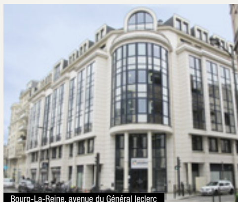
Bourg-La-Reine, avenue du Général Leclerc
