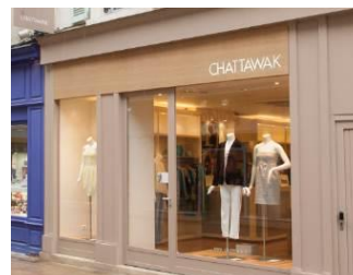
29-31 rue des Sieurs à Alençon (61)
