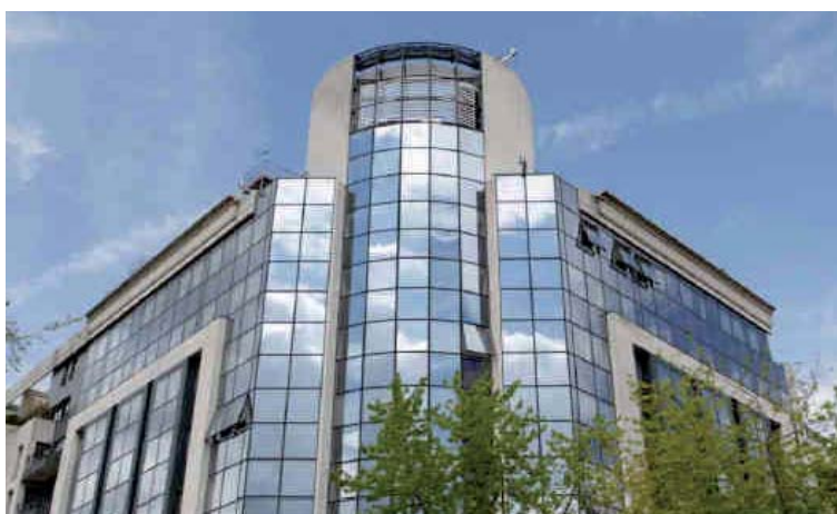
Boulogne Billancourt (92) – rue de Silly
