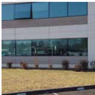
ILLKIRCH (67) Le Fermat Rue Sébastien Brandt
