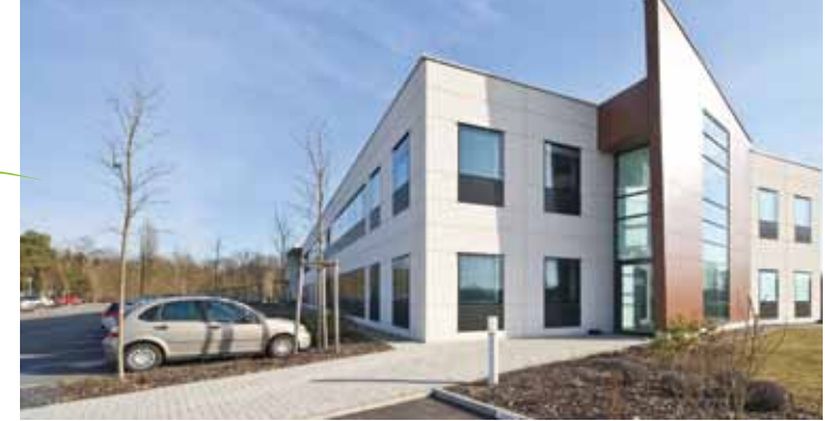
ILLKIRCH (67) Boulevard Sébastien Brant
