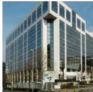
NOISY LE GRAND (93) Avenue Montaigne
