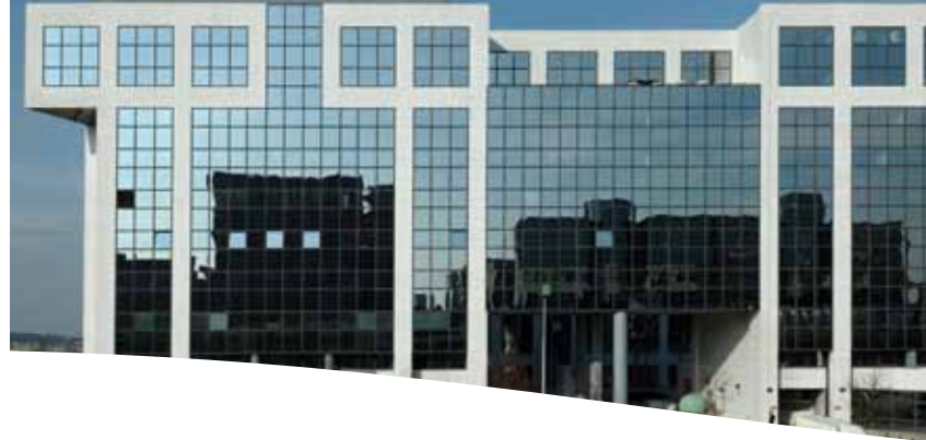
NOISY LE GRAND (93) Avenue Montaigne
