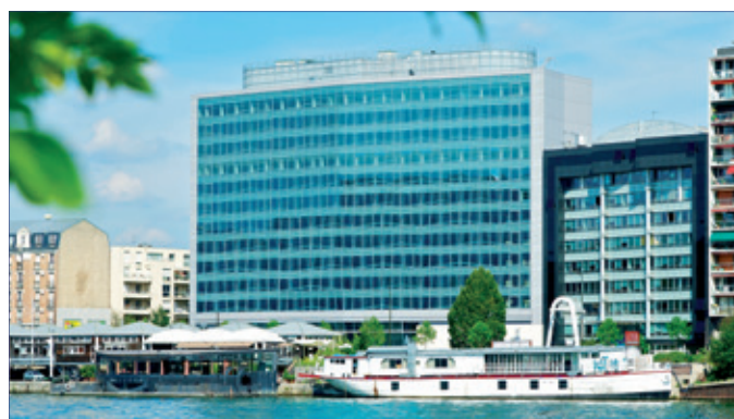
Iléo - Quai Le Gallo - 92100 BOULOGNE-BILLANCOURT
