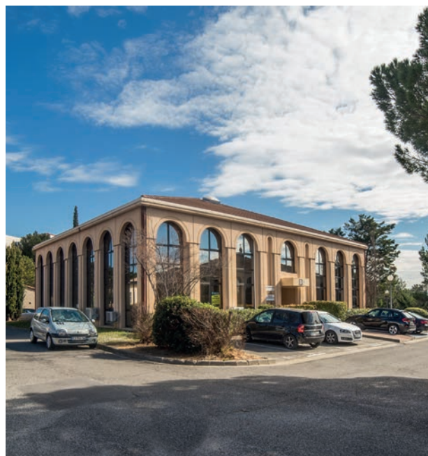
AIX EN PROVENCE (13) - Avenue de la Grande Thumine
