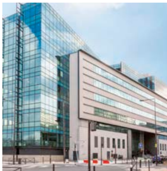
IVRY-SUR-SEINE (94), «Atrium Rive Gauche».
