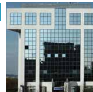
NOISY LE GRAND (93) Avenue Montaigne
