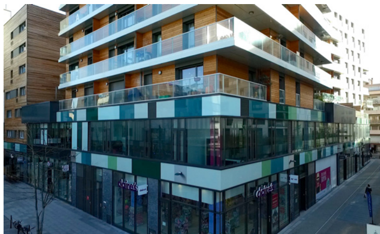
Chablais parc - 74100 Annemasse
