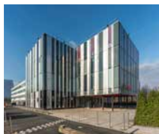
Geodis/Locked-up/Grenke/Ciamt Carré Sénart - Lieusaint
